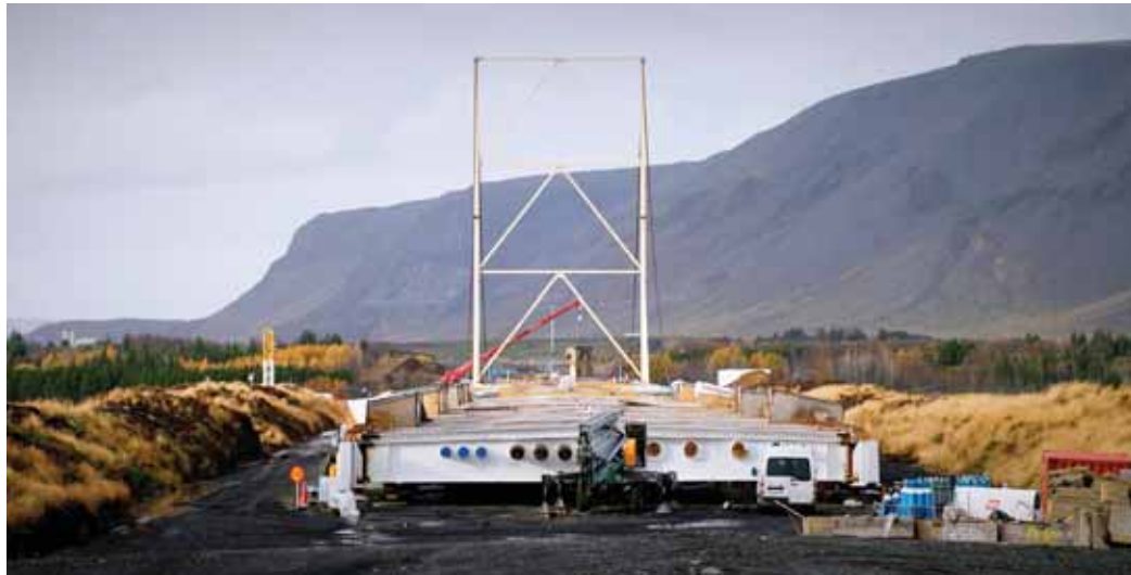
Brúargólfíð hefur verið sett saman á landi og er nú undirbúið fyrir flutning yfir Ölfusá. Í bakgrunni sést mastur nýju brúarinnar. Ljósmynd: Vegagerðin.
