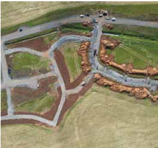
Jarðtækni vinnur að uppbyggingu nýrrar götu og göngustíga við hverfið á Borg. Mynd: gogg.is.
