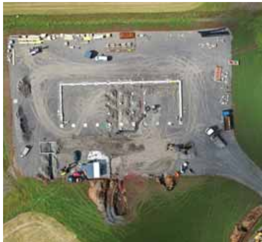
Unnið er að undirstöðum nýrrar björgunarmiðstöðvar en reising hússins á að hefjast í haust. Mynd: gogg.is.
