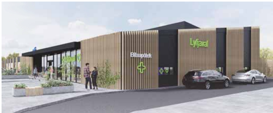
Ný ásjón gamla Húsasmiðjuhússins, horft að bílaapóteki Lyfjaval. Mynd: Arkís arkitektar
