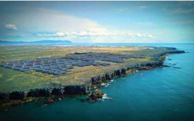
Laxeldisstöð Landeldis hf. vestan við Þorlákshöfn. Framkvæmdir eru hafnar og verklok eru áætluð árið 2030.
