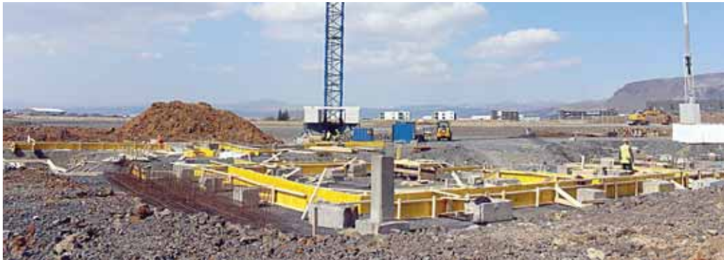
Frá byggingarsvæðinu þar sem Stekkjaskóli mun rísa.
