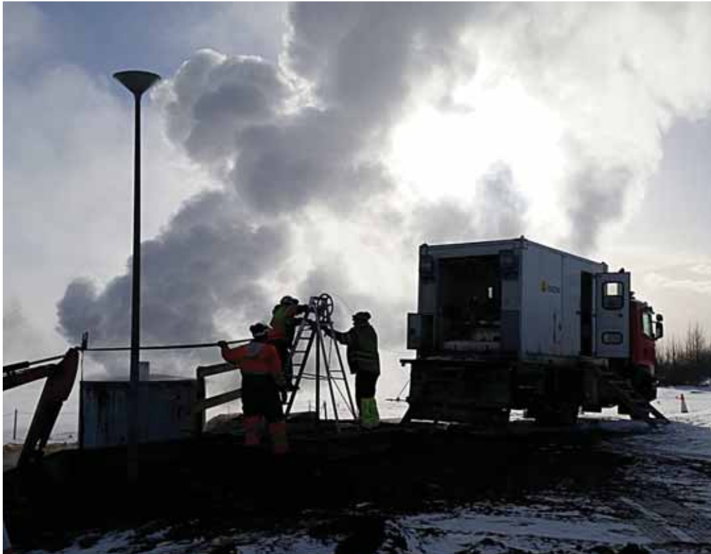
Niðurstetning háhitadælu undirbúin.
