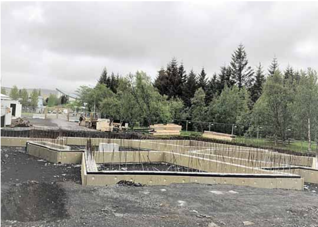
Viðbygging við grunnskólann í Hveragerði
