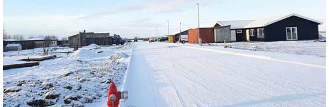
Byggingaframkvæmdir við Gunnarsgerði. Mynd: ÁLK
