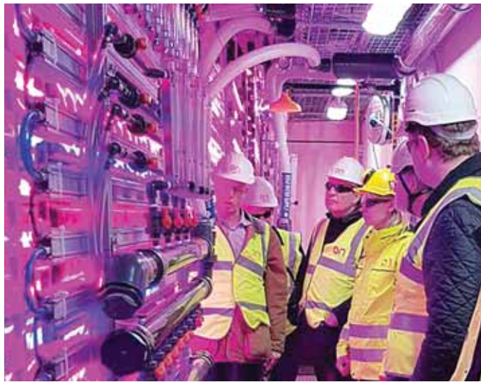
Tilraunastöð Algaenovation við Hellisheiðarvirkjun. Mynd: ON.
